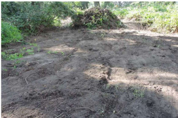
Abbildung 21: Abtrag Oberboden und Bewuchs
