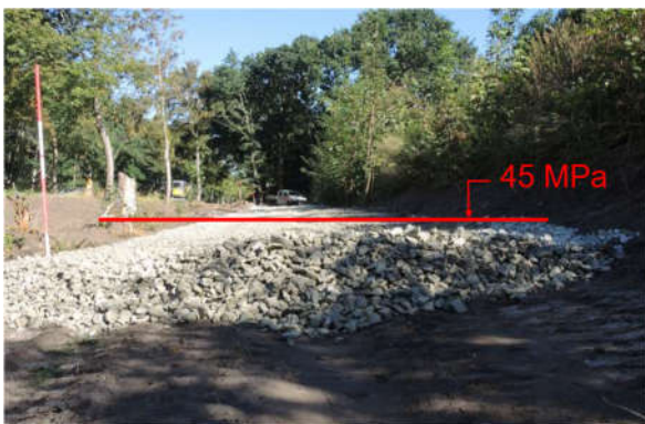
Abbildung 23: Einbau Grobschotter als Unterbau
