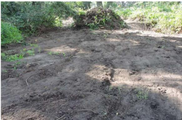
**Abbildung 21: Abtrag Oberboden und Bewuchs**
