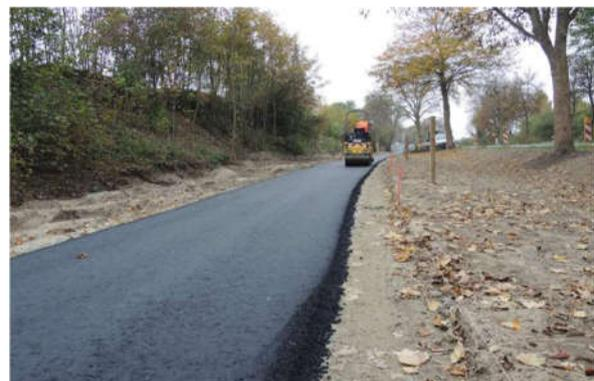
**Abbildung 24: Einbau Oberbau nach RStO**
