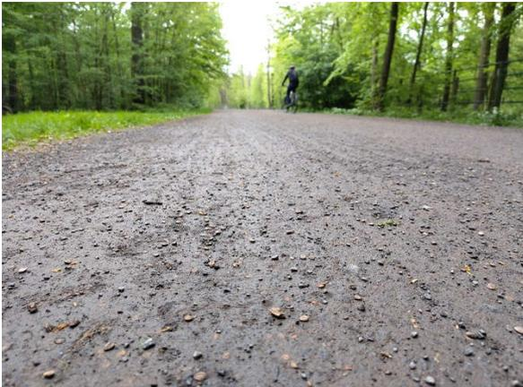
Abbildung 8: Wassergebundene Deckschicht (Leipzig)
