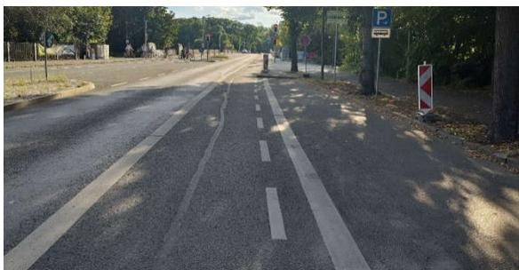
Um sogenannte Dooring-Unfälle<sup>b</sup> zu vermeiden, kann zwischen der Fahrbahn und einem anliegenden Längsparkstreifen ein Sicherheitstrennstreifen markiert werden.<sup>63</sup>
