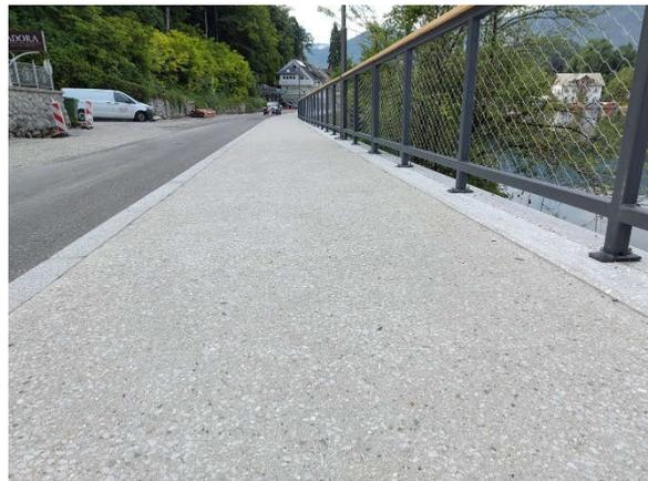
Abbildung 38: Geschliffener Waschbeton
