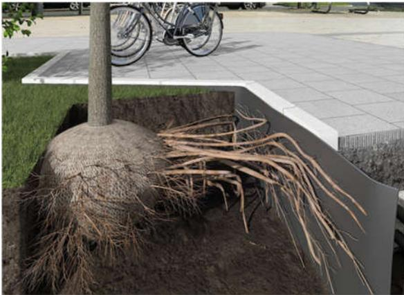
**Abbildung 14: Punktueller Wurzelschutz**
