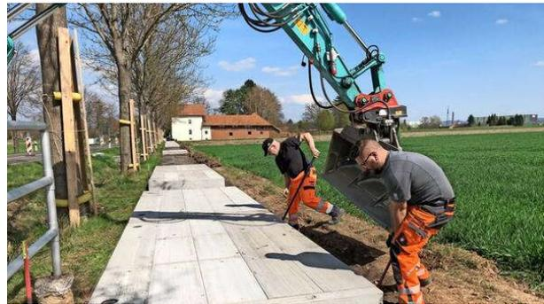
**Abbildung 25: Einbau von Wurzelbrücken aus Stahlbeton**
