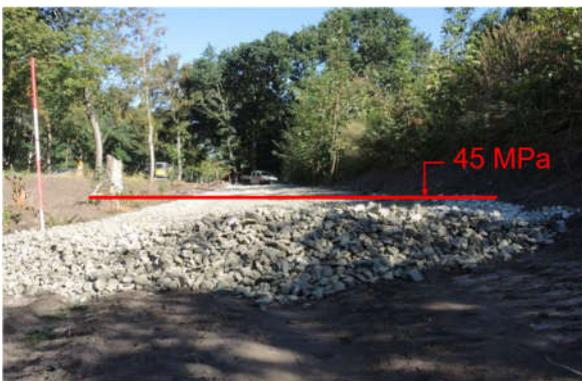
**Abbildung 23: Einbau Grobschotter als Unterbau**
