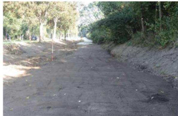
**Abbildung 22: Vorbereitete Fläche mit Wurzellockstoff**
