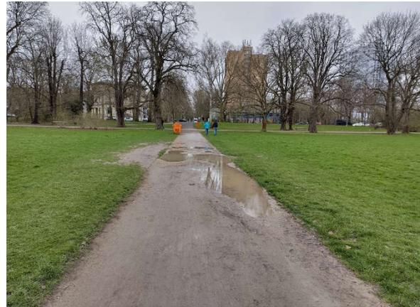
Abbildung 9: Wassergebundene Deckschicht (Leipzig)
